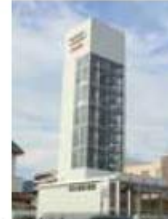
●タワーパーキングシステム
