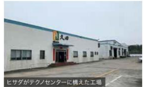
ヒサダがテクノセンターに構えた工場
