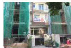
両脇で新築工事
