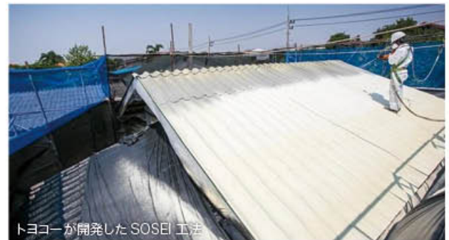
トヨコーが開発した SOSEI 工法
