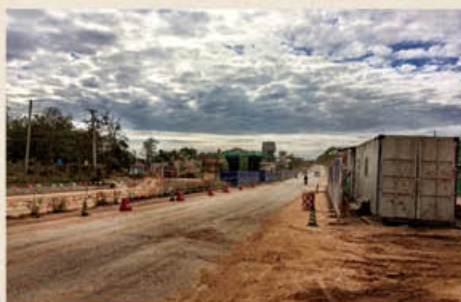
ビエンチャンの中老鉄道建設現場。新線は街を変化させる。
