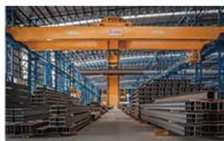
チョンブリに建設した配送センター
