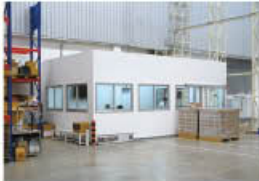
工場内オフィス設置
