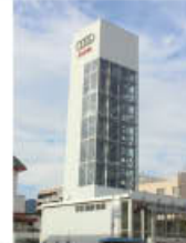
●タワーパーキングシステム
