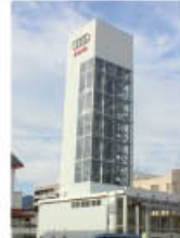
●タワーパーキングシステム
