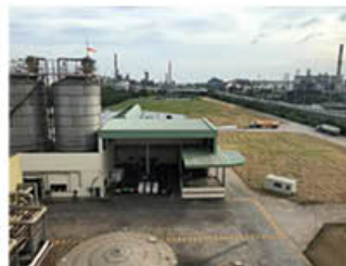
新工場の建設予定地
