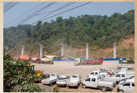
土埃を上げるラオス国境ポーテンの中老鉄路建設現場。
