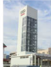
●タワーパーキングシステム
