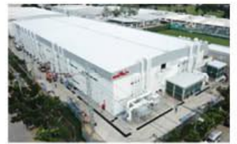
EMIフィルタ生産用の新生産棟
