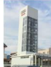
●タワーパーキングシステム
