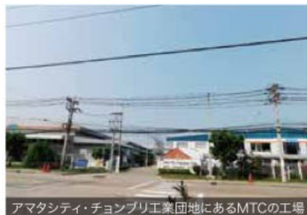
アマタシティ・チョンブリ工業団地にあるMTCの工場
