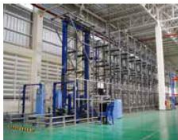
常温用自動倉庫
