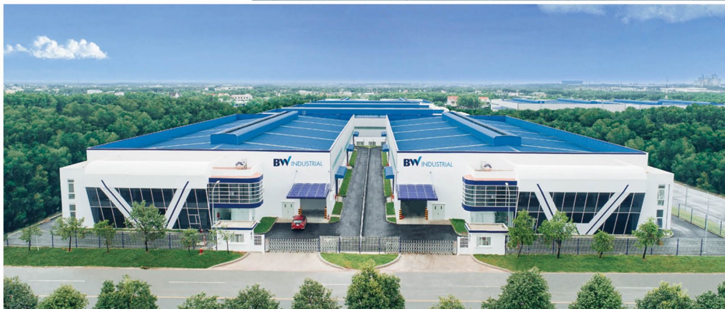
BW Industrial Development JSC (BWID) が開発したミーフック3工業団地（レンタル工場）の外観
