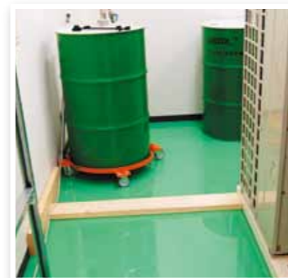
社員が手作業により木材で設備の固定を行っている。
